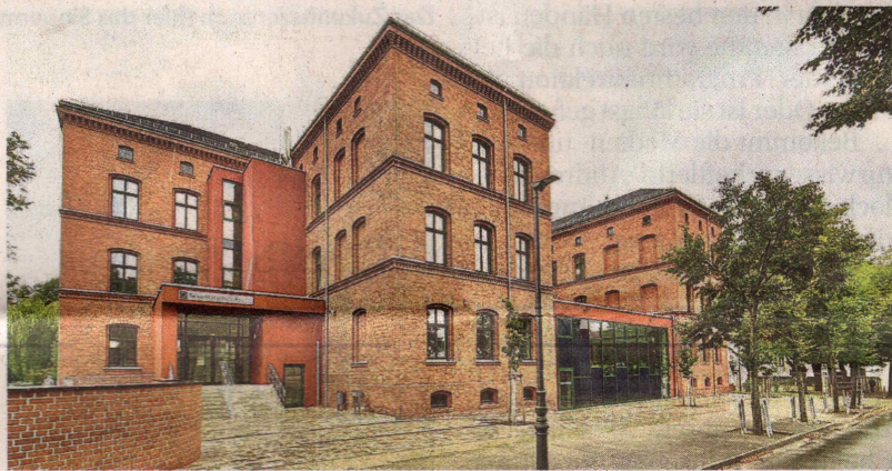
Das sanierte Haus 1 der Sekundarschule Roßlau in der Goethestraße
